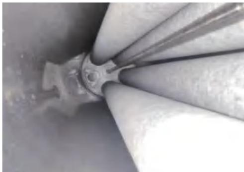
(7) 还原滤芯固定压板、过滤罐盖子，注意密封条是否安装平整以及上方压力表对应方向；并用卡箍锁紧；
