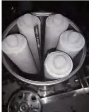
(5) 取出旧滤芯，拆下滤芯上下插件接口堵头，注意下方旧垫圈不要遗漏在精密滤芯过滤器内；
